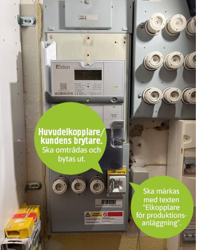
Mätartavla med en ny brytare för både huvudkopplare/kundens brytare och elkopplare för produktionsanläggningen.
