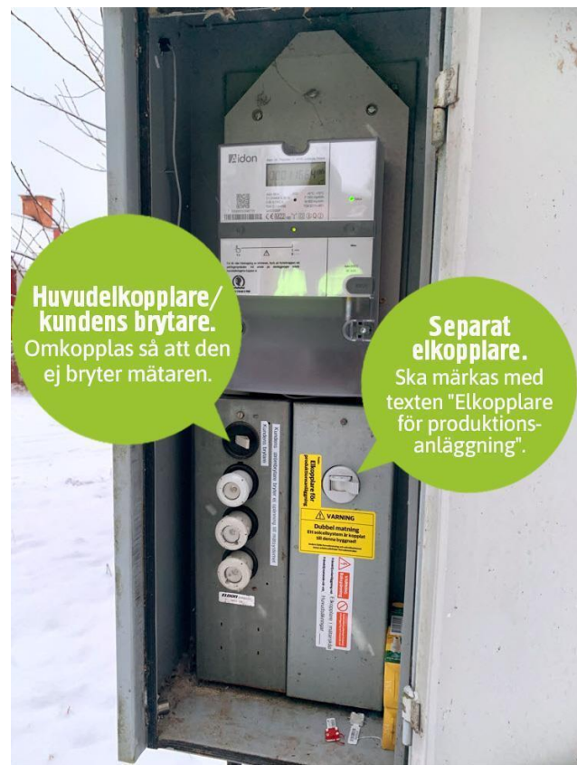
Mätarskåp med huvudkopplare och elkopplare för produktionsanläggningen.
